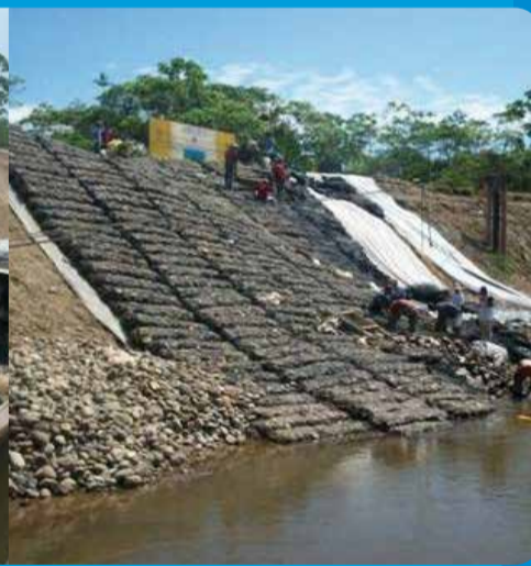
Fotografías 5 y 6. Instalación de Geoesteras
