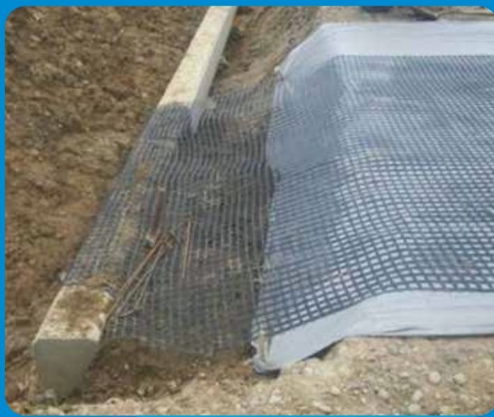
Fotografías 2 y 3. Anclaje de las Geoesteras
