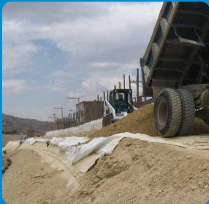
Construcción de jarillón en suelo reforzado
