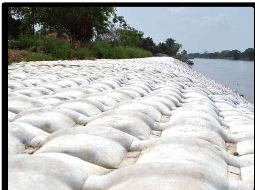
Fotografía 1. Revestimiento con COLCHACRETO® ARTICULADO
