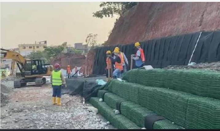
Foto 5. Suelo reforzado con geomalla FORTGRID UX y revestimiento en la cara con manto TERRATRAC TRM 50
