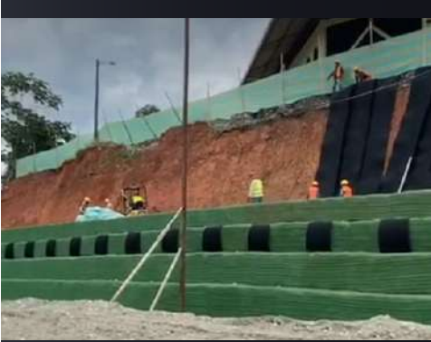
Foto 7. Conformación de capas de suelo y Geomalla Fort grid UX
