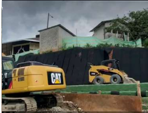
Foto 8. Colocación de Geodren PERMADRAIN en el espaldar y entre capas de suelo reforzado
