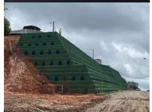
Foto 9. Muro de contención concluido con fachada en manto TERRATRAC TRM
