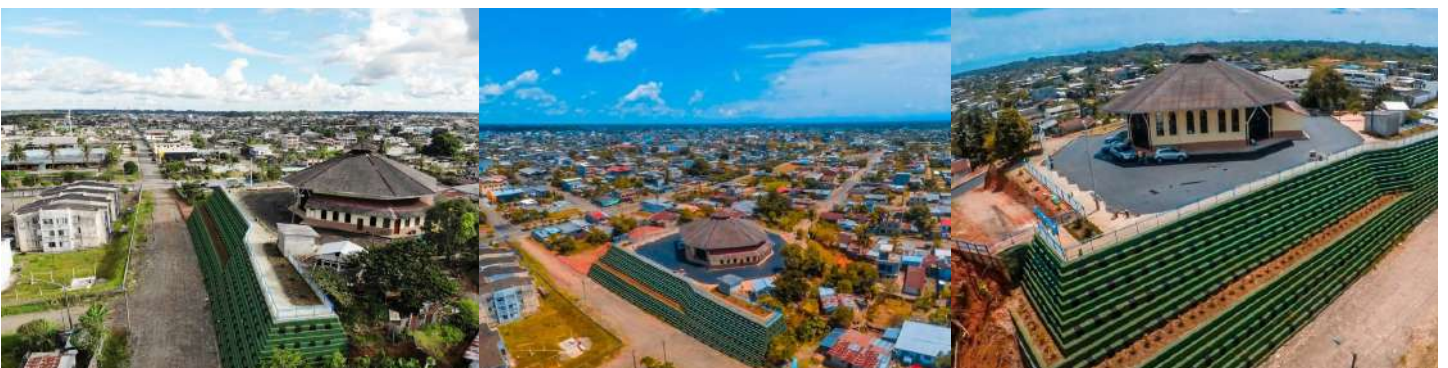
Foto 10. Muro de contención concluido con obras de urbanismo y mirador turístico
