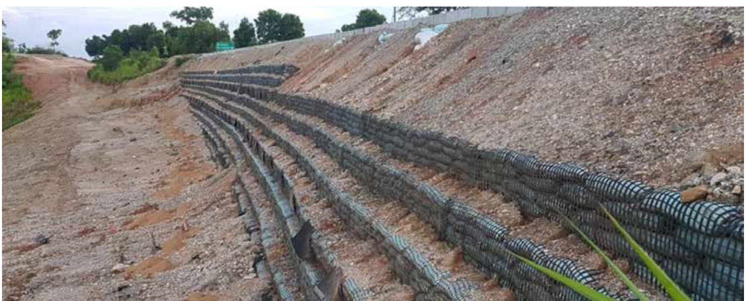
Fotografía 6. Panorámica de la estructura terminada
