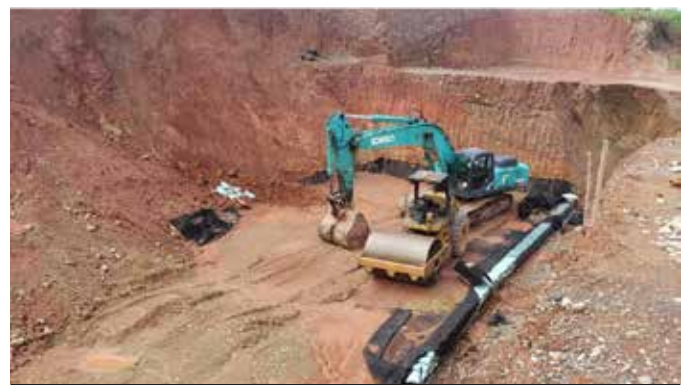
Fotografía 2. Cimentación del muro. Se aprecia el refuerzo con geomalla FORTGRID UX 100, fachada en suelo confinado con Geobolsas PROPYBAG
