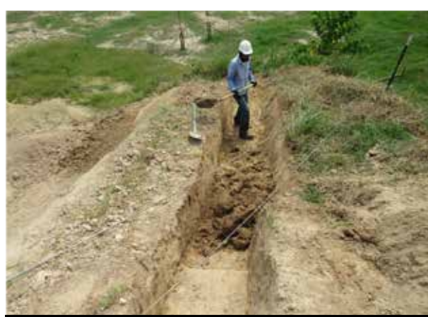
Fotografía 1. Talud a proteger de los agentes erosivos.
