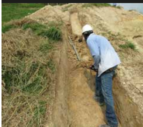
Fotografía 3. Excavación y perfilado del perímetro de la zanja de coronación.
