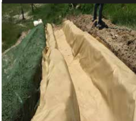
Fotografía 4. Estructura de protección en la última fase de construcción.
