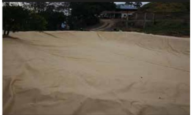
Fotografía 4. Instalación del Impertex.
