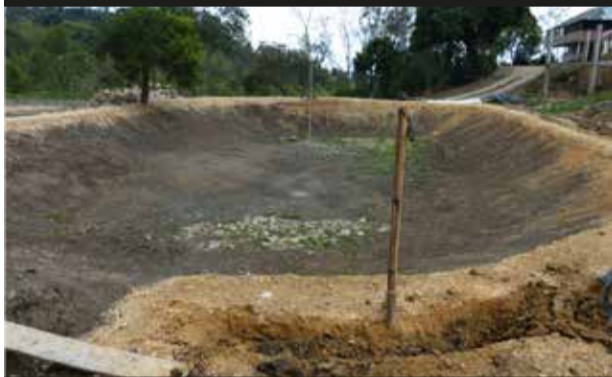
Fotografía 3. Preparación del terreno.
