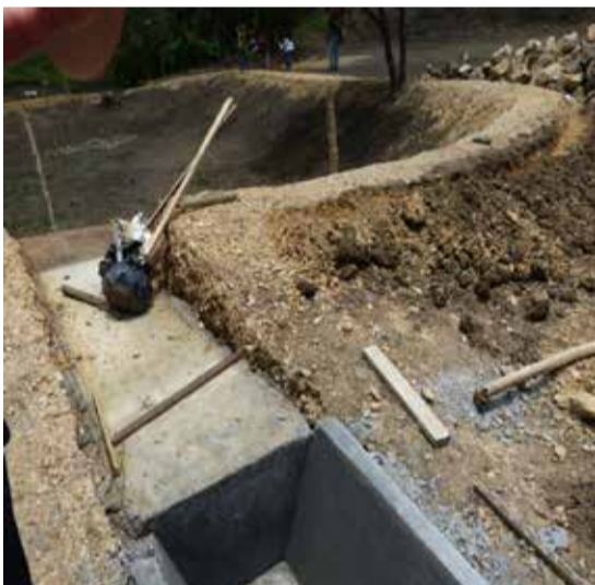
Fotografía 2. Obras complementarias para el manejo de aguas.
