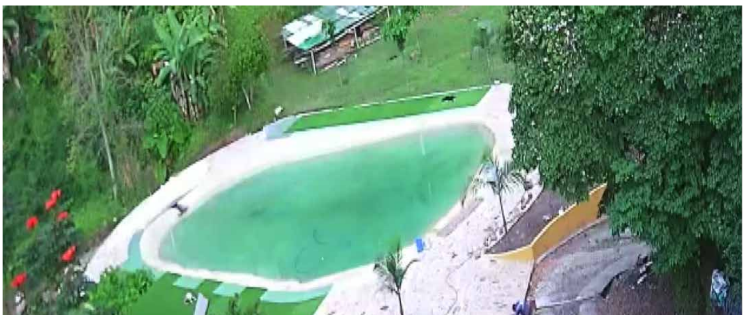
Fotografía 5. Vista aérea de la piscina revestida y adecuación de zonas aledañas.
