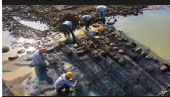
Fotografía 5. Instalación y llenado de los colchones prefabricados en HIDROMALLA GEOESTERA® 300 en la base de la estructura.
