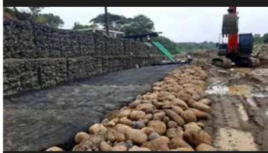
Fotografía 7. Estructura de protección en la última fase de construcción.
