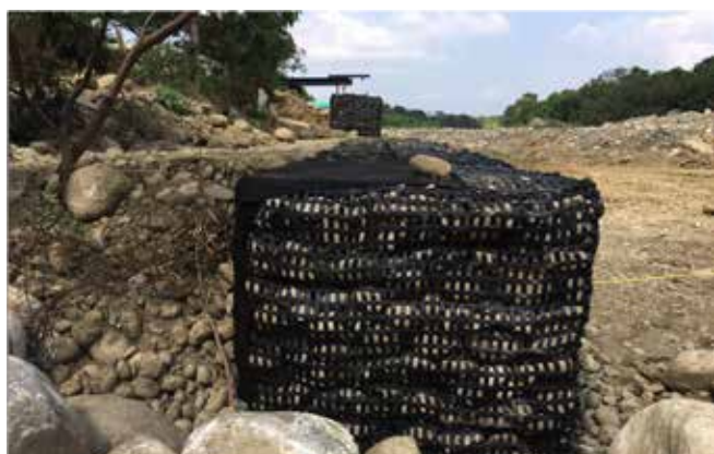
Fotografía 2. Construcción del primer nivel de la estructura de protección de la margen fluvial.
