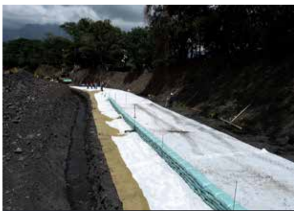
Foto 3. Cimentación del muro. Se aprecia el refuerzo con geotextil FORTEX BX 60, fachada en suelo confinado con Geobolsas PROPYBAG y revestimiento en la cara con armadura textil FORTSHIELD
