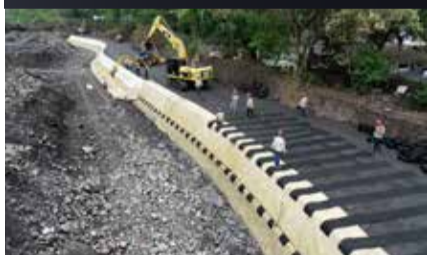
Foto 4. Sistema de subdrenes horizontales en geodrén PERMADRAIN 450
