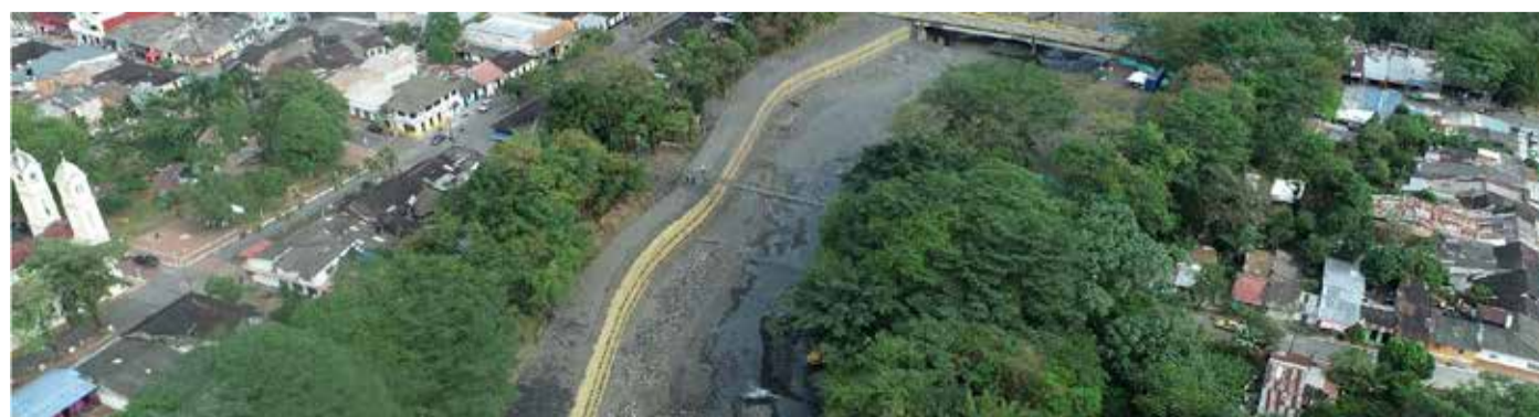
Foto 7. Panorámica aérea de la estructura terminada
