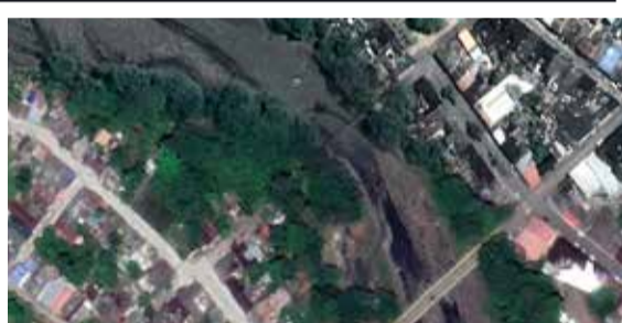
Foto 1. Erosión en la orilla izquierda en la zona del puente peatonal.
