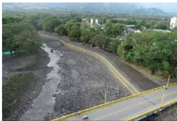
Foto 2. Estructura en suelo reforzado para control de inundaciones y estabilización del cauce.
