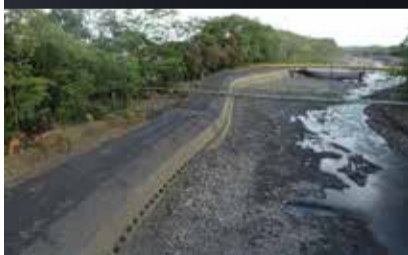
Foto 5. Recubrimiento en la cara con armadura textil FORTSHIELD
